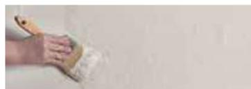
**2 - BADIGEONNER À LA BROSE** l'enduit à l'aide d'une brosse large en plusieurs couches successives croisées sur une épaisseur minimum de 2 mm.
