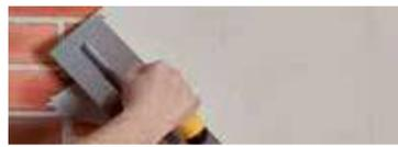
**1 - APPLIQUER À LA LISSEUSE**, sur une épaisseur minimum de 2 mm afin de garantir ses propriétés physiques.
