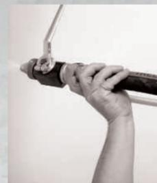
La projection se fait à l'aide d'une machine qui utilise une source d'air. À l'aide d'une lance, la machine permet une dépose régulière du produit avec un réglage air sur la machine. Les enduits à projeter sont utilisés pour des chantiers de moyenne et grande taille. L'encombrement et le poids sont une limite de la machine sur les chantiers à étages.
