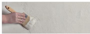
**2 - BADIGEONNER À LA BROSE** l'enduit à l'aide d'une brosse large en plusieurs couches successives croisées sur une épaisseur minimum de 2 mm.
