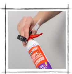
Après avoir positionné l'embout applicateur sur l'aérosol, dépoussiérez le support à jointoyer.
