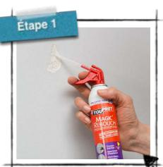
Pressez l'applicateur pour déposer l'enduit de manière à recouvrir le trou à reboucher.
