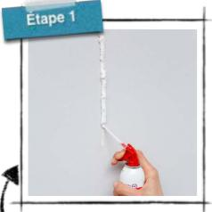
Pressez l'applicateur pour déposer l'enduit de manière à recouvrir la fissure à reboucher.
