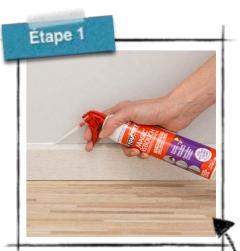
Utilisez directement l'aérosol pour combler le joint entre la plinthe et le mur.
