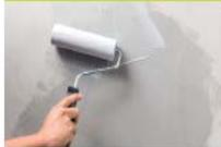
**1 - DÉPOSER** la matière avec le rouleau Liss PLANEON® SYSTEM. Elle s'applique par zones successives de 0,5 m<sup>2</sup> de formes irrégulières. Il est important de croiser les gestes afin de ne pas avoir de démarcation. Appliquer de bas en haut pour éviter les coulures sur l'enduit partiellement sec.
