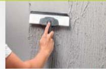
**2 - ÉGALISER.** Répartir la matière fraîche déposée avec le lisseur à lame crantée.
