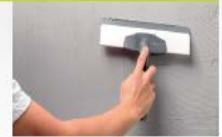
**3 - SURFACER.** Lisser dans le frais avec le lisseur à lame Liss souple, tout en laissant quelques cilles, coups de lames, vaguelettes.
