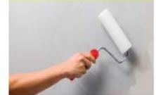
**1 - DÉPOSER** le vernis, après le DECOR'PROTECT au rouleau laqueur 5 mm en une couche. Satiner, nuancer et foncez également. En fonction des conditions ambiantes, du resserrage du grain et de la nature du support, une deuxième couche peut être nécessaire.
