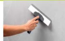
**2 - RATISSER** l'excédent en passant le lisseur à lame Liss souple, PLANEON® SYSTEM, avec des gestes aléatoires. Ne pas racleur uniquement à la verticale ou à l'horizontale mais dans tous les sens. Satiner et nuancer légèrement le décor après séchage. Foncez légèrement. En fonction des conditions ambiantes, du resserrage du grain et de la nature du support, une deuxième couche peut être nécessaire.
