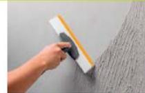
**5 - RATISSER** dans le frais avec le lisseur à lame Liss dure avec un angle fermé, les motifs créés en 1<sup>re</sup> passe se révéleront ainsi. Pour un décor plus nuancé et onir au toucher, repasser délicatement sur l'enduit le lisseur à lame Liss dure afin de resserrer le grain.
