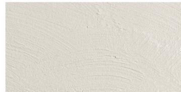
Aplicar la masilla con ayuda de una brocha ancha o cepillo, en sucesivas capas cruzadas, aplicando un espesor mínimo total de 2 mm. en dos capas cruzadas para garantizar sus propiedades físicas.
