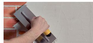
**1 - APPLIQUER À LA LISSEUSE**, sur une épaisseur minimum de 2 mm afin de garantir ses propriétés physiques.
